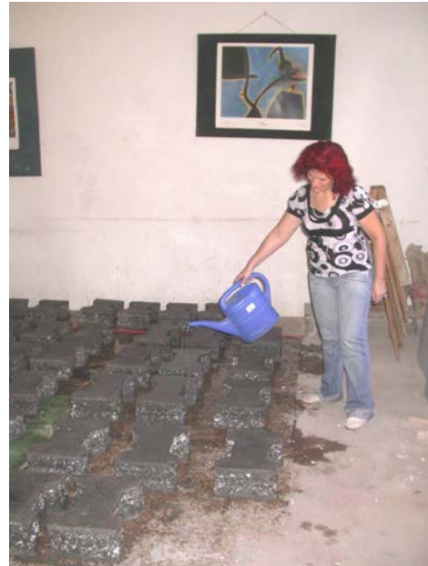
Imágenes 33 y 34 Producción y fragüe del Bloque H al pie de obra
