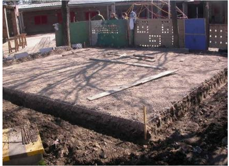
Imagen 31 y 32- Imágenes de la platea en construcción
